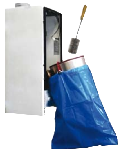
Wartungsposition 2: Reinigung des Wärmetauschers mit Reinigungsbeutel und Bürste (Zubehör)
